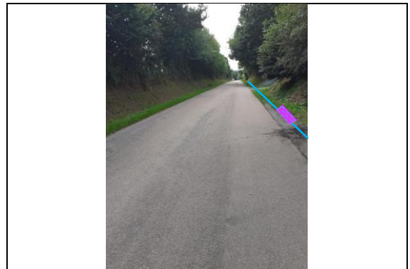
Emplacement de la future chambre PCH_BCY50_001_FM0003.
