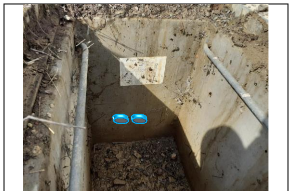
Futurs percements de la chambre FT_50027_FT1 par 2Ø42/45, un 3 ème fourreau en attente à 15cm. Fin du PGC02.
