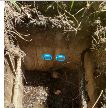
Futurs percements de la chambre FT_50027_185 par 2Ø42/45, un 3 ème fourreau en attente à 15cm.
