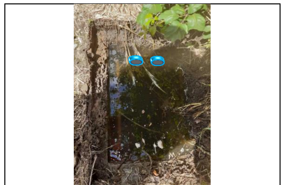
Chambre L1T FT_50027_184 et ses futurs percements par 2Ø42/45, un 3 ème fourreau en attente à 15cm. Fin du PGC01.
