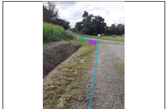
Arrivée du GC à la chambre PCH_BCY50_001_FM0005 puis parcours vers L2T FT_50027_FT1.
