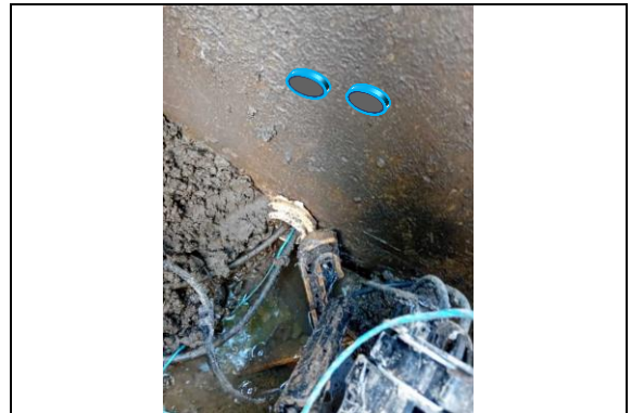
Futurs percements de la chambre FT_50027_222 par 2Ø42/45, un 3 ème fourreau en attente à 15cm.
